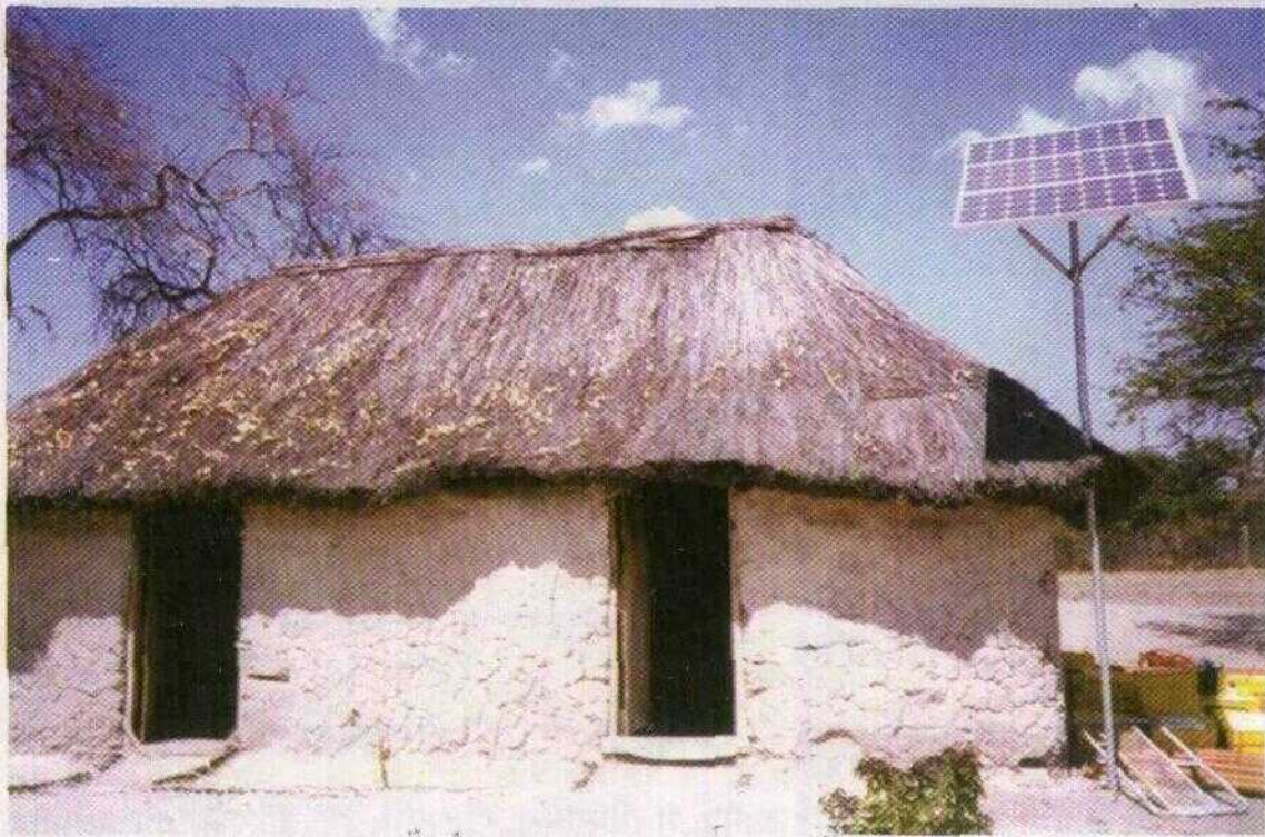
VIII.ख.4 नामीबिया के एक गांव स्पिट्जकौप में सी ई एल द्वारा एस पी वी शक्ति चालित घरेलू प्रकाश प्रणाली ।
