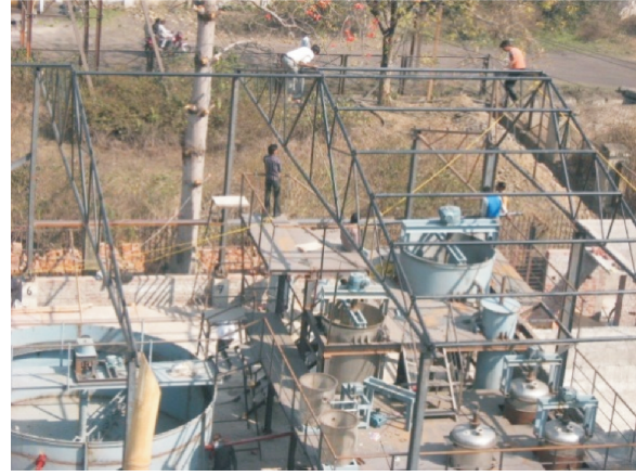
चित्र. 25000 लिटर/दिन कोयला खदान जल पुनरुद्धार संयंत्र का अधिष्ठापन कार्य प्रगति पर है
