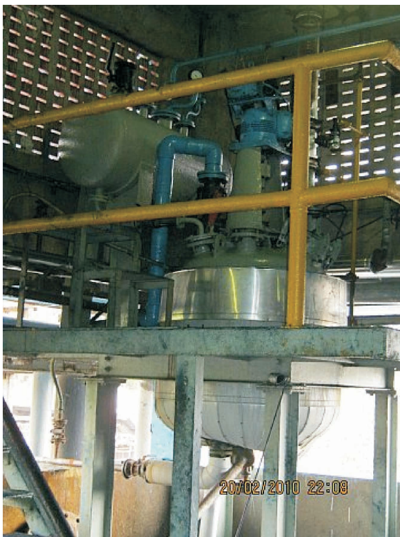
चित्र. लोना इंडस्ट्रीज लि., मुंबई में उत्प्रेरक उत्पादन में मुख्य रिएक्टर
