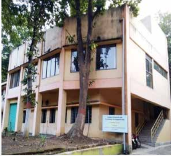
सीएसआईआर-सीएमईआरआई में सीआरटीडीएच भवन
